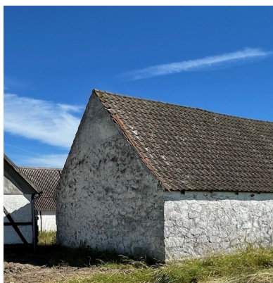
Eksempler på mure i kløvede marksten og den smukke bue
